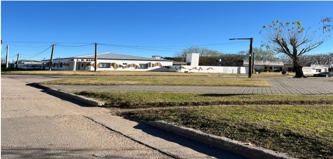
Plaza sin rampas de acceso.
